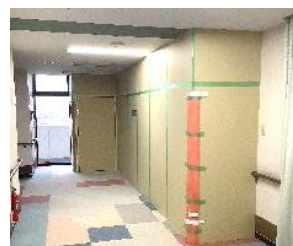
3階居室工事中の養生壁
