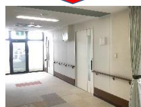
3階居室完成後
